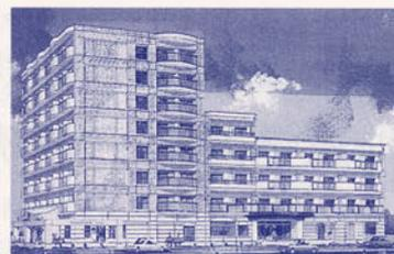
この建物は、鉄筋コンクリート造8階建、ワンルームマンション形式(1部屋の面積21㎡)となっており、次のような概要になっています。
